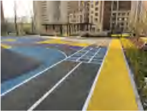
道路广场区现状 (2022.03)
